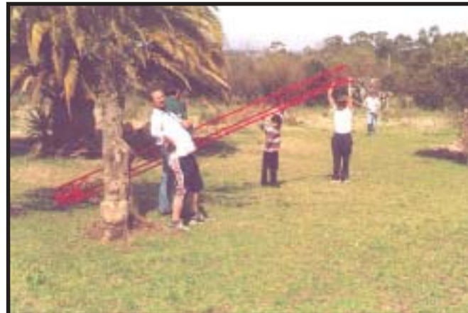
Foto: Luego del trabajo de pintura se comenzó con el armado de la torre.
