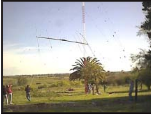
Foto: Elevando la antena Mosley para instalar a 24 metros en la torre n°1 del Parque.
