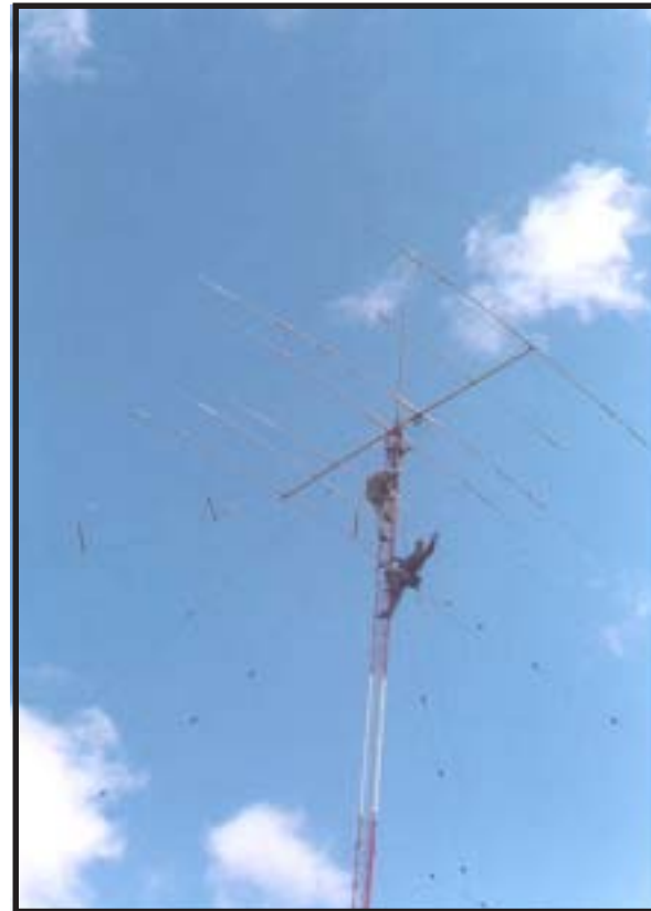
Foto: Julian CX5BE y Jorge CX6DAP, terminando de instalar la antena Mosley.
