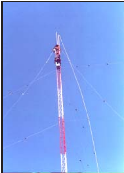
Foto: Instalando la Torre N°1 de 24 metros.
