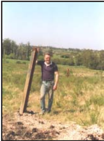
Foto: Ricardo CX6ACY, durante la instalación de los amarres de las torres.
